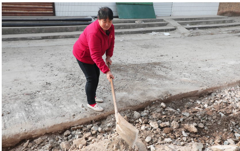
杨九花在水网改造施工现场义务劳动
